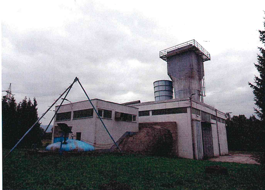
Slika 1: Ventilatorska postaja Pesje
