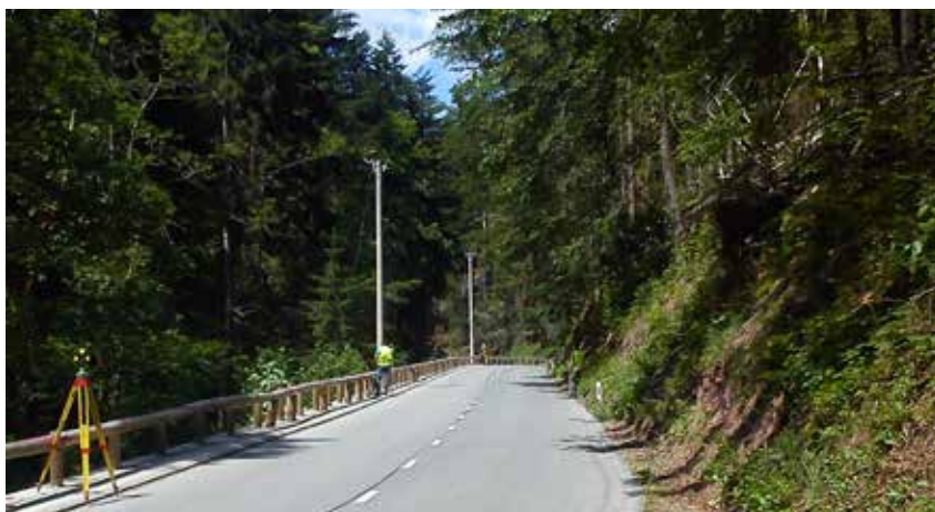
Terenska izmera daljnovoda na območju Občine Žiri
