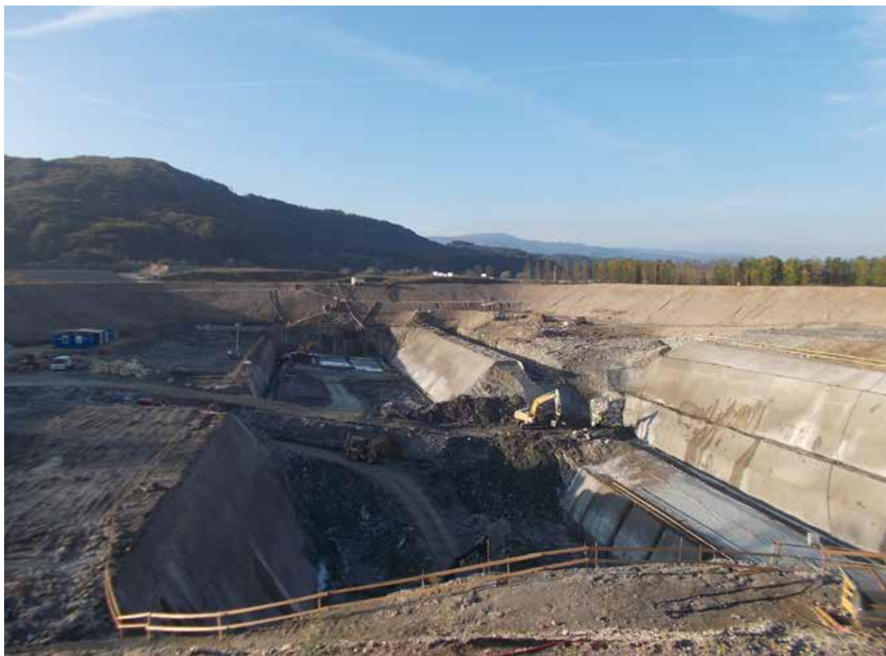
Z vgradnjo različnih geotehničnih sider zagotavljajo stabilnost brežin izkopa, s tem pa tudi pogoje za varno delo v 34 metrov globoki gradbeni jami. (foto: Tadej Vodušek)
