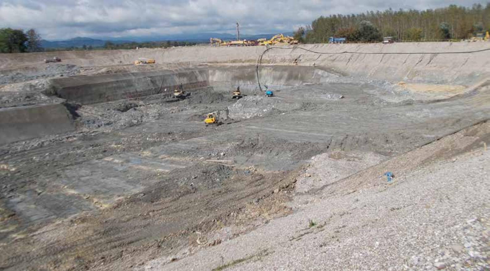
Gradbena jama HE Brežice (foto: Tadej Vodušek)
