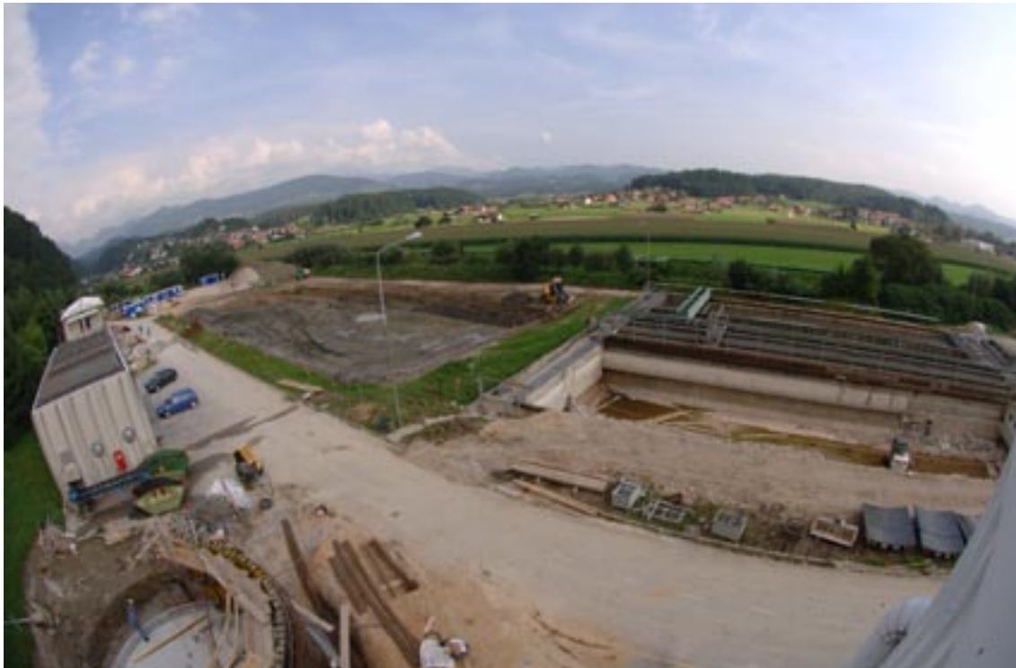
Začetek izgradnje 2. faze CČN (foto: A. Videtič)
