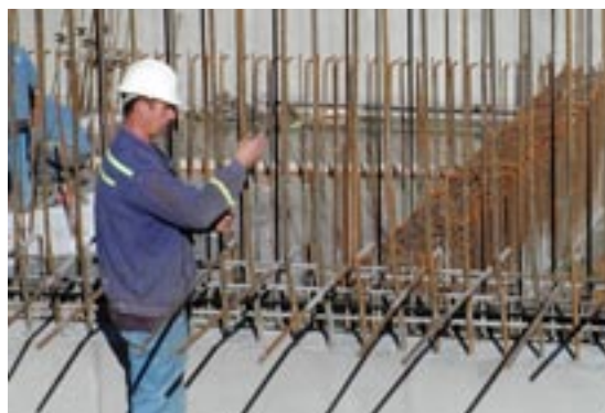
Pred betoniranjem mora biti armatura čvrsto povezana (Foto: E. Šterbenk)
