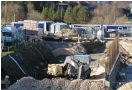
Na gradbišču je kljub novembrskemu mrazu zelo živahno. (Foto: E. Šterbenk)
