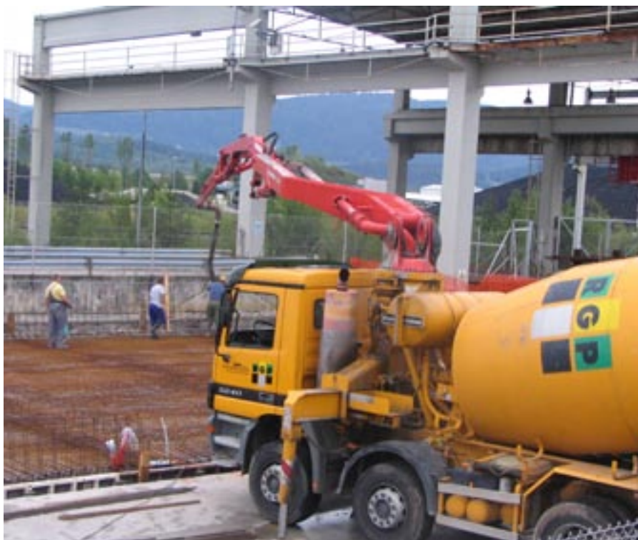
Betoniranje AB plošče bodočega skladišča popravljene opreme.
