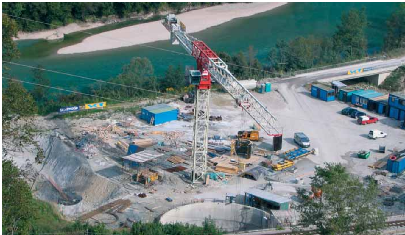
Pogled na gradbišče z ustjem strojničnega jaška
