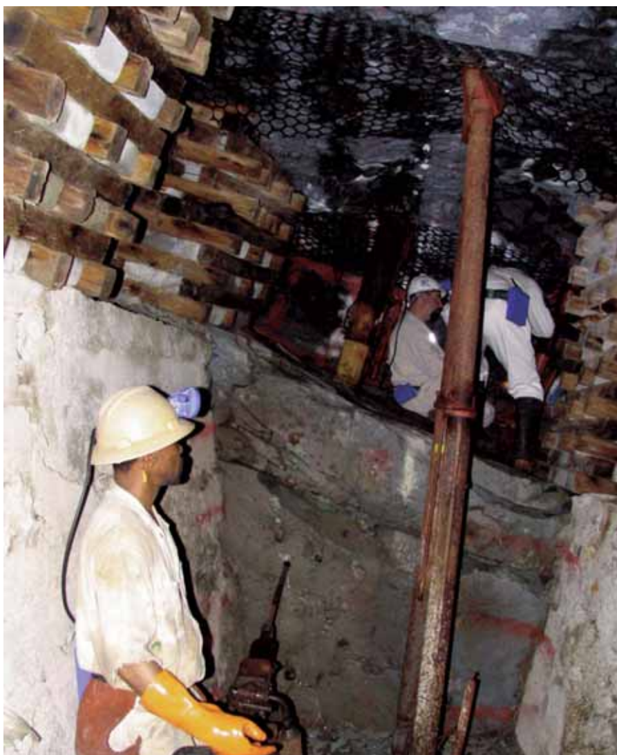
Oprema na odkopu
