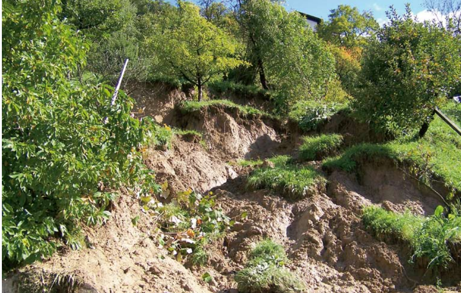
Plaz pri Berločnikovih v Ložnici je ogrožal tudi stanovanjsko hišo.
