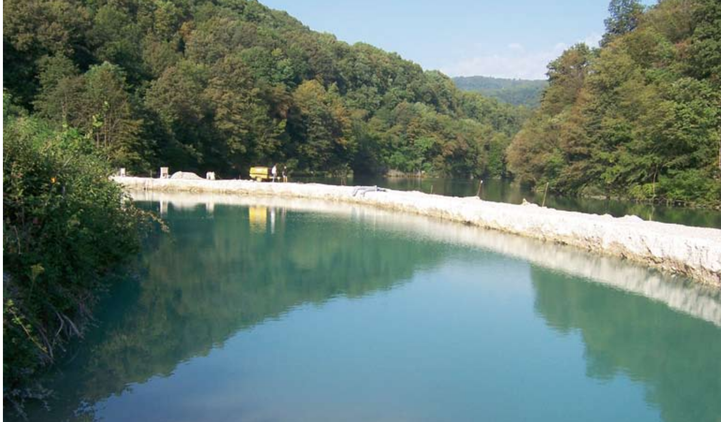
Del vodotesne pregrade v ČHE Avče v fazi zaključevanja. Dno gradbene jame je vsaj 7m pod gladino Soče.
