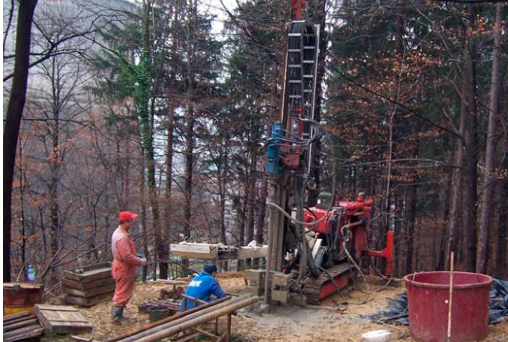
Začetek vrtanja prve strukturno-raziskovalne vrtnice na lokaciji DP-1; v ozadju eden od hladilnih stolpov, ki bo prav tako odstranjen.
