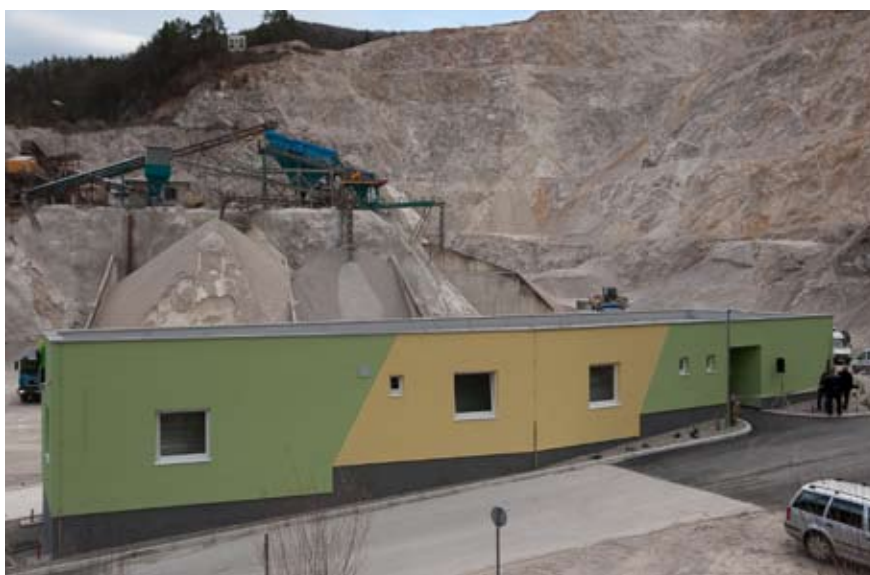
V kamnolomu so dogradili zgradbo, v kateri je bil dispečerski prostor ob tehtnici za kamene agregate, in dobili suhe, svetle in tople poslovne prostore.
