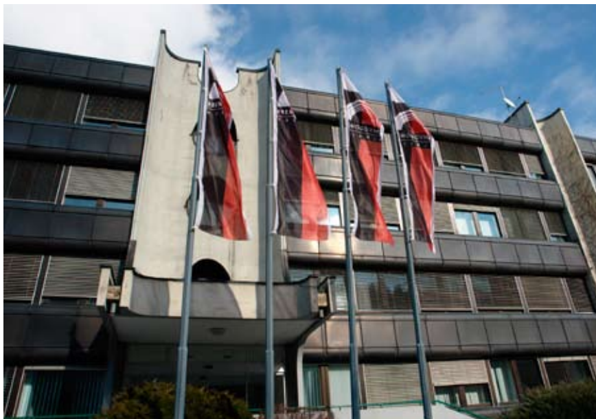
Upravna zgradba je energetsko potraten objekt.
