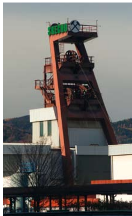
Eden ključnih razvojnih projektov Premogovnika Velenje je izgradnja novega izvoznega jaška NOP-II.
