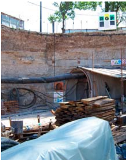
Portal tunela s sv. Barbaro
