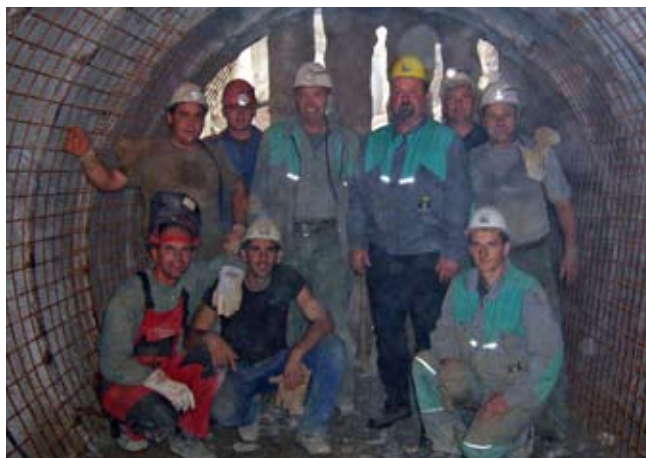
Skupinski posnetek ob preboju tunela iz ene gradbene jame v drugo; v ozadju so vidni jet grouting piloti za varovanje druge gradbene jame.
