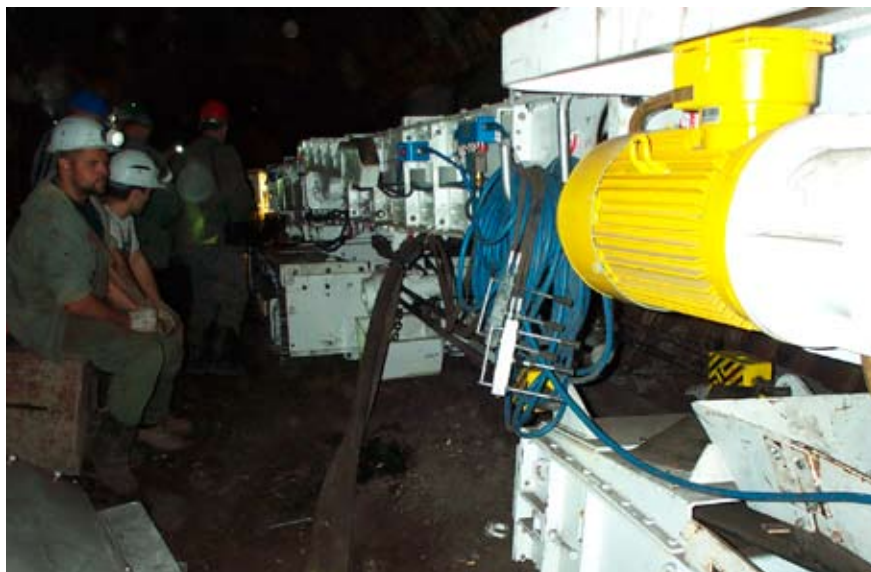
Med montažo transporterja v jami
