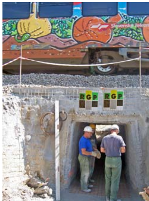
Detajl med gradnjo propusta; zgoraj je potniški vlak Slovenskih železnic
