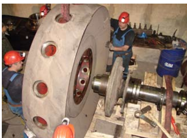
Demontaža rotorskega venca z gredi
