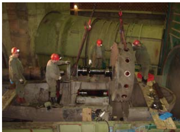
Dvig rotorja iz ležišča
