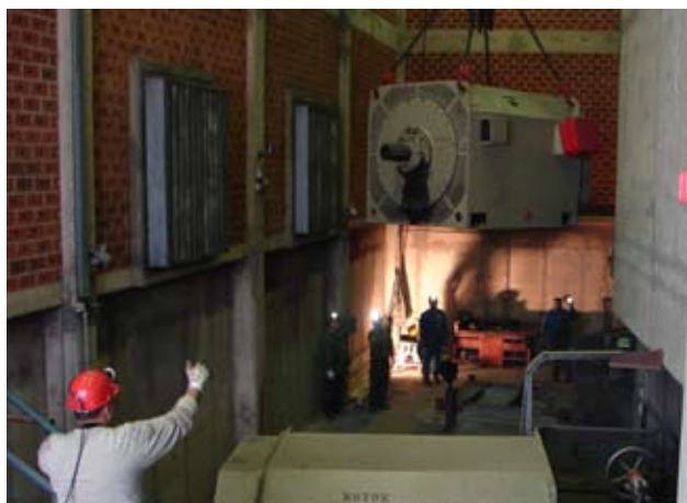
Demontaža elektromotorja, teže 15.000 kg, na katerem je zunanji izvajalec opravil revizijo.
