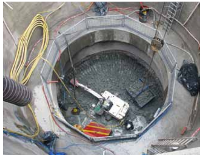
Prikaz trenutnega stanja delovišča pri izvedbi druge faze pripravljalnih del.
