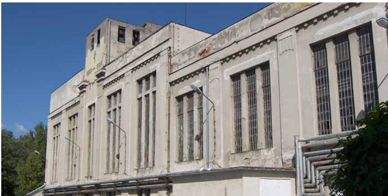
Stara elektrarna, kjer bo po prenovi sedež RCE
