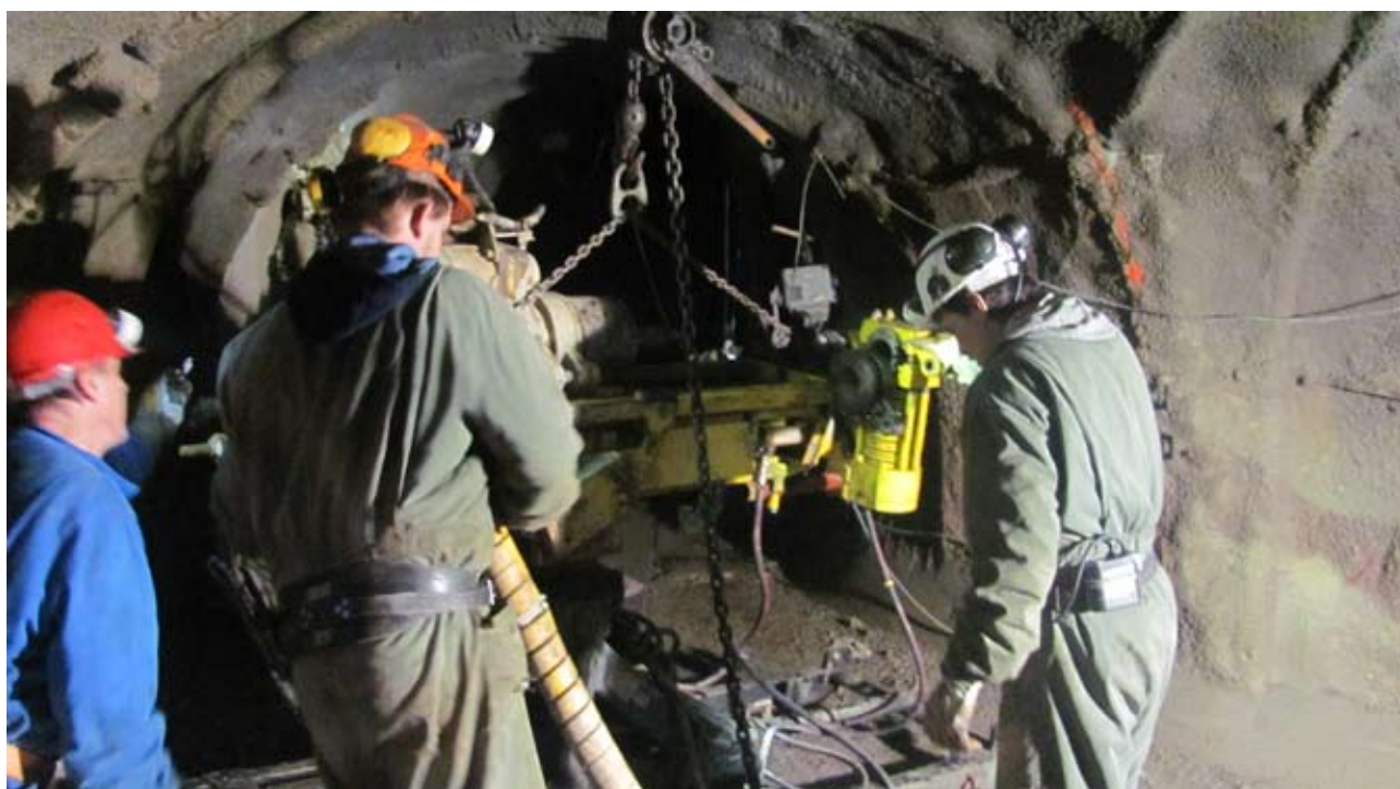
Priprava vrtalne garniture za vrtanje
