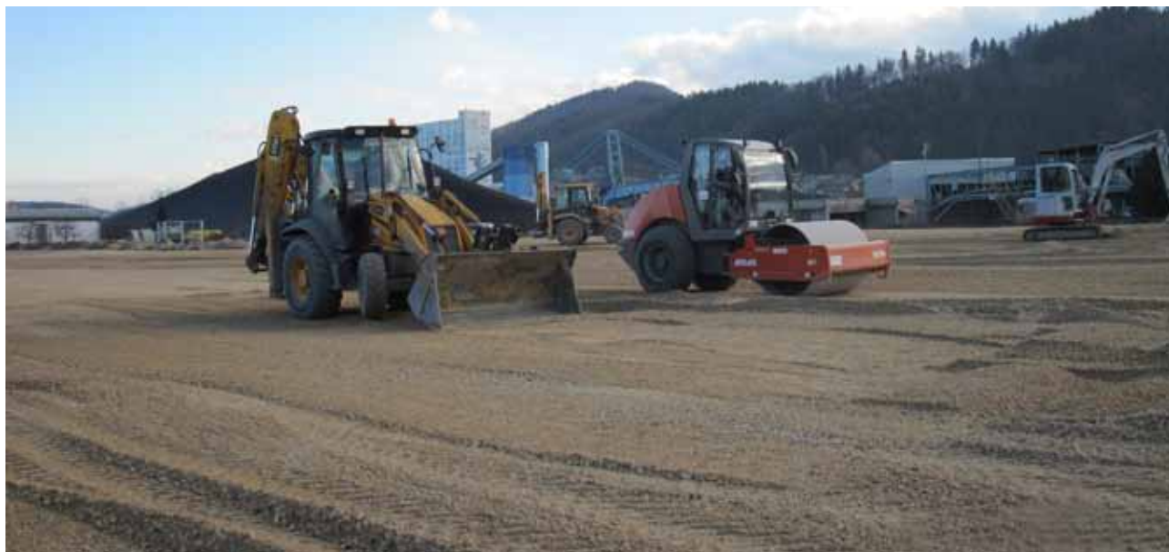
Pogled na delovišče izgradnje platoja
