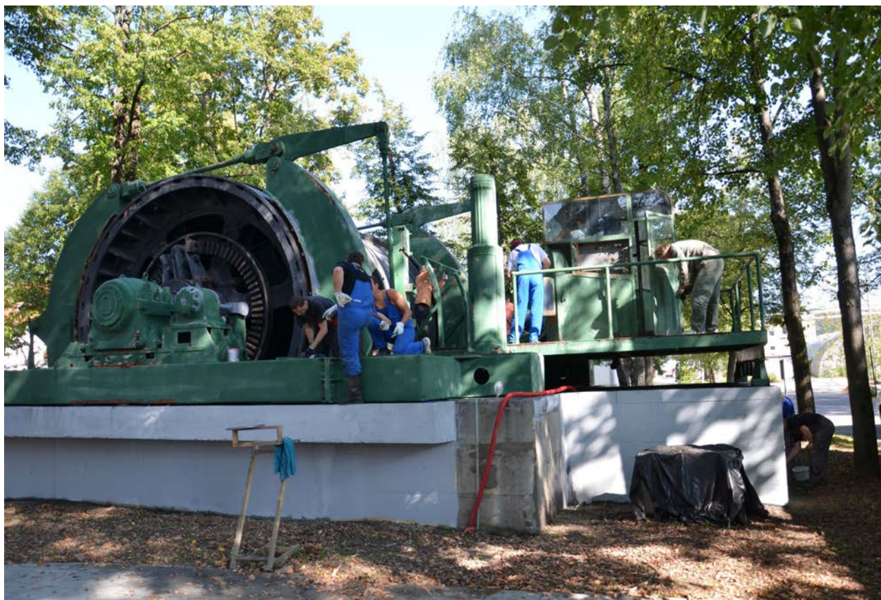
Čistili, zaščitili in barvali so temelj in konstrukcijo izvoznega stroja Dominion. (foto: Mrki)
