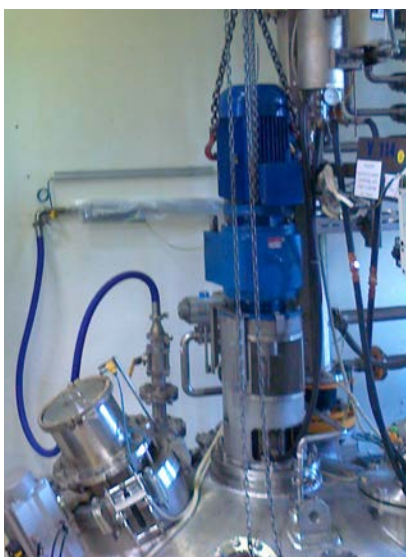
Montaža elektromotorjev po opravljenem servisu (foto: B. Širnik)
