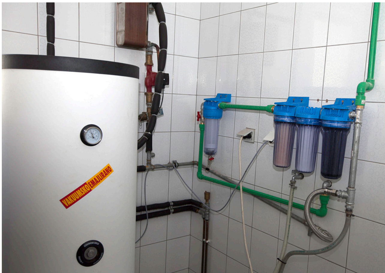
Filtracijski sistem AquaVallis v mlekovodu (foto: Hans)
