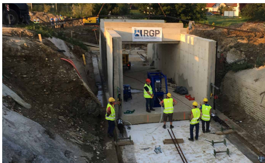
Premikanje objekta, teže 250 ton, na lokacijo – 9. 8. dopoldne
