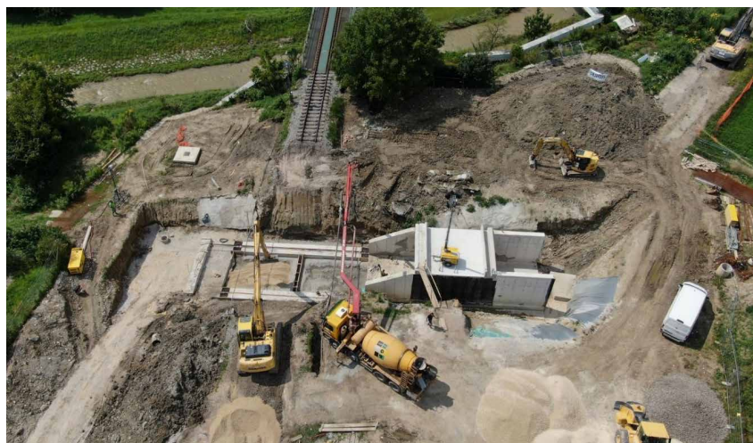
Pogled na gradbišče ob izvedbi temeljev narivne proge – 8. 8. dopoldne
