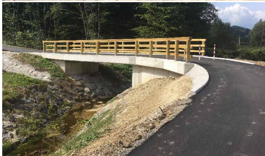
Izvedba pilotov za temeljenje mostu M1 in pogled na most ob zaključku del
