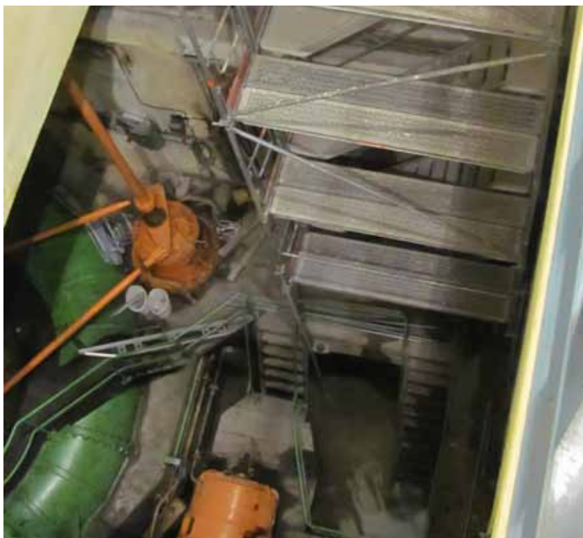
Na nivoju 120,50 metra nadmorske višine leži montažni plato, ki je hkrati tudi generatorska etaža. (foto: Marko Ranzinger)
