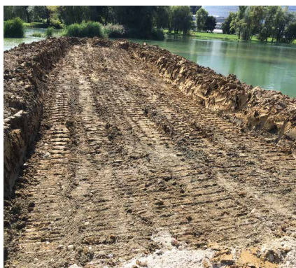
Izvedba ločilnega glinenega nasipa in AB-propusta z zapornico
