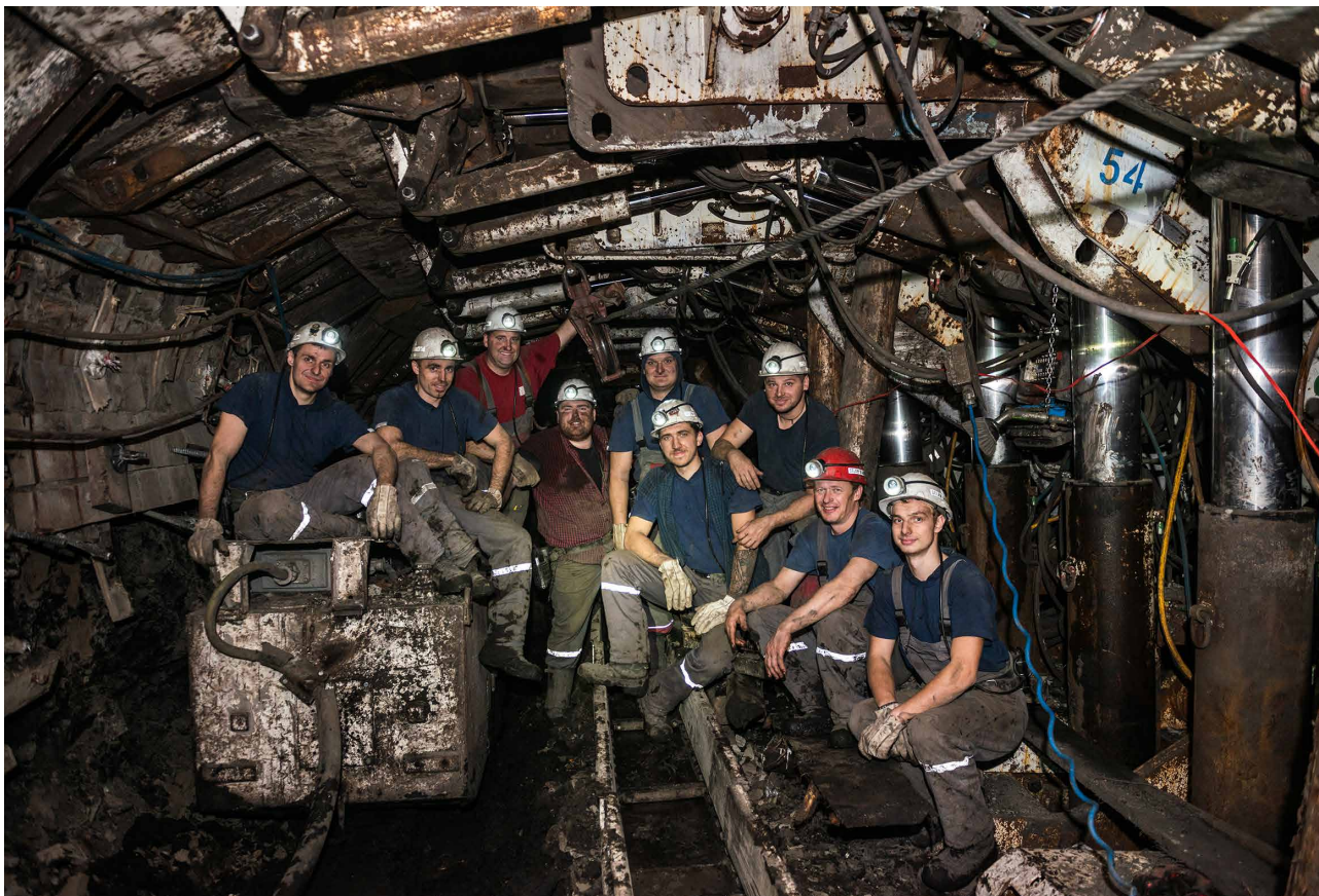
Ekipo Proizvodnje in Jamske elektroslužbe v pri vgradnji opreme na odkopu k. -95/C (foto: Miran Beškovič)
