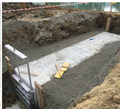
Izvedba ločilnega glinenega nasipa in AB-propusta z zapornico
