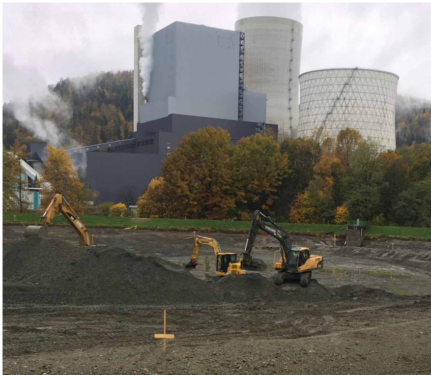
Poglabljanje plitvine z izkopnimi bagri
