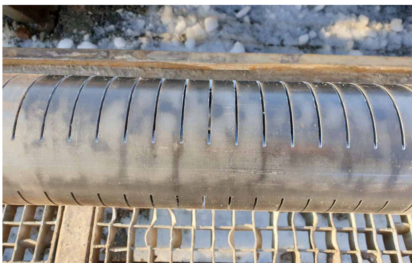
Vgrajeni jekleni slotirani filtri s sloti 3mm
