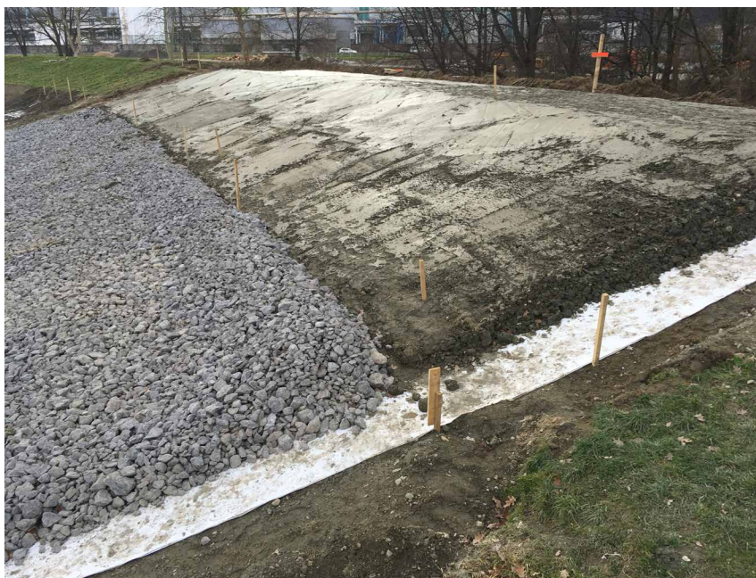
Polaganje bentonitnega kompozita
