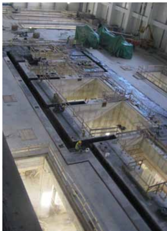
Pogled na turbinsko mizo po končanih gradbenih delih
