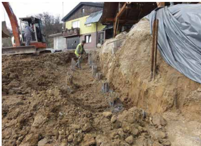
Izdelani AB piloti za izgradnjo temelja podpornega zidu
