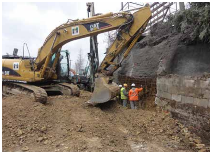
Izvedba torkreta za varovanje brežine med izkopom
