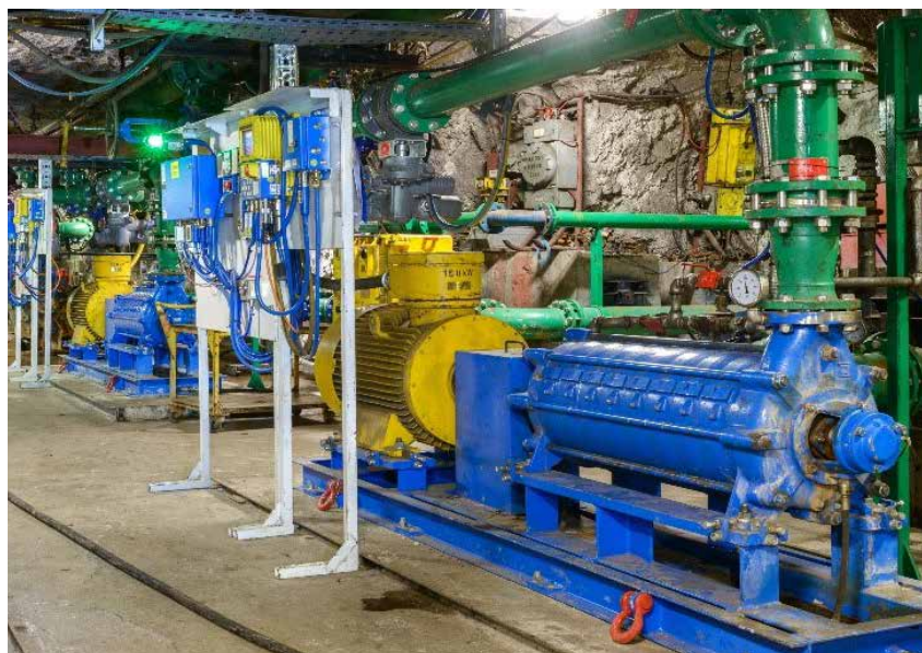
Primerjava konfiguracij črpališča s starimi črpalkami (zgoraj) in novimi črpalkami s procesno krmilno opremo (spodaj). (foto: Miran Beškovnik)
