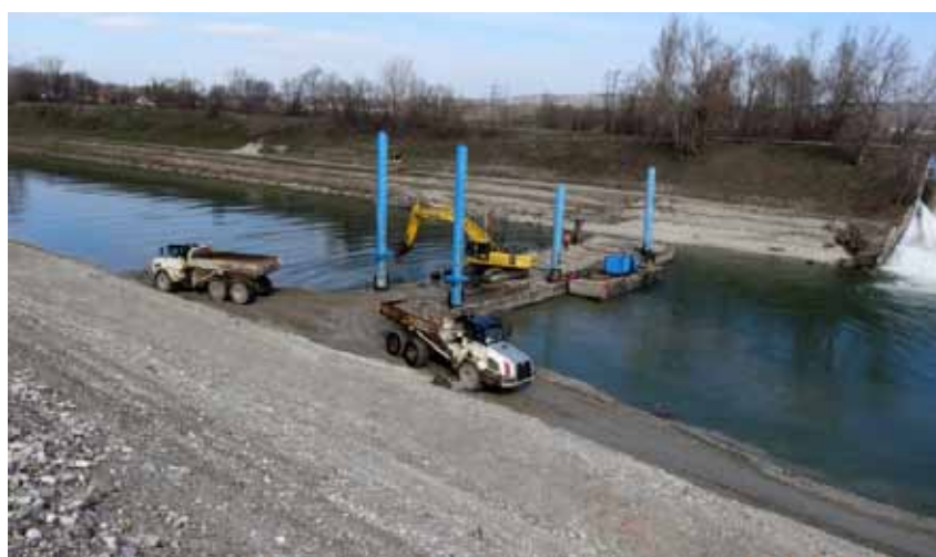
Izkop materiala pod vodo s pomočjo pontona in bagra na njem
