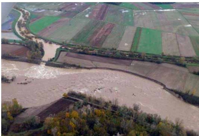
Porušitev nasipa in vdor poplavne vode v odvodni kanal HE Formin na prvi lokaciji
