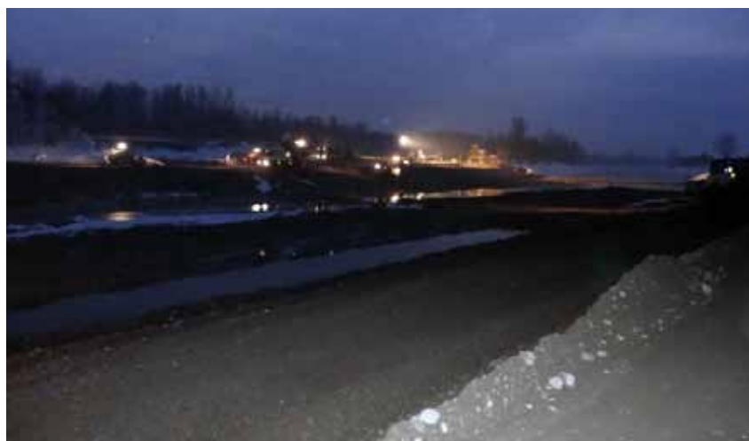
Izvajanje del tudi ponoči z velikim številom gradbenih strojev
