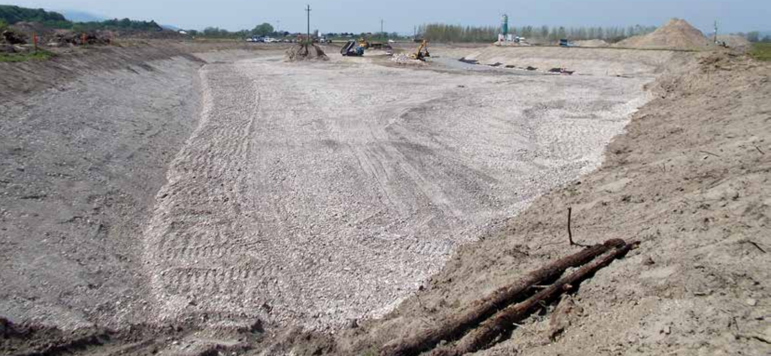
Izkop obtočnega kanala (foto: Miran Hudournik)
