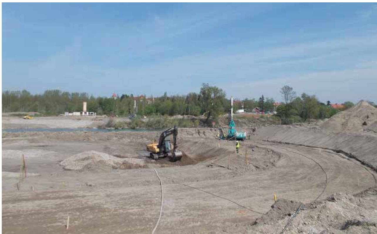
Izvedba tesnilne zavese z jet grouting piloti (foto: Miran Hudournik)
