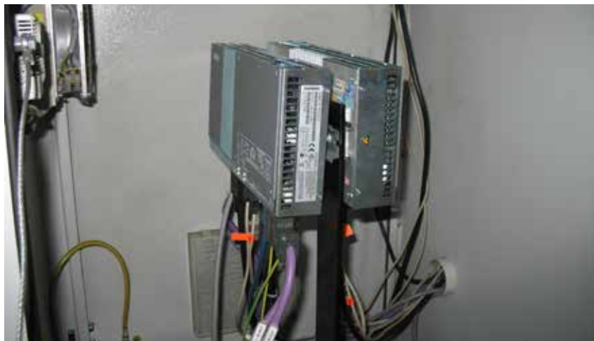
Nadzorna računalnika SIMATIC IPC427C (foto: Miran Penšek)
