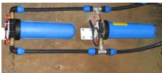
Filtracijski sistem MB Big Blue UNO v vodnem zajetju Prejnuta pri Idriji (foto: Matej Vošnjak)
