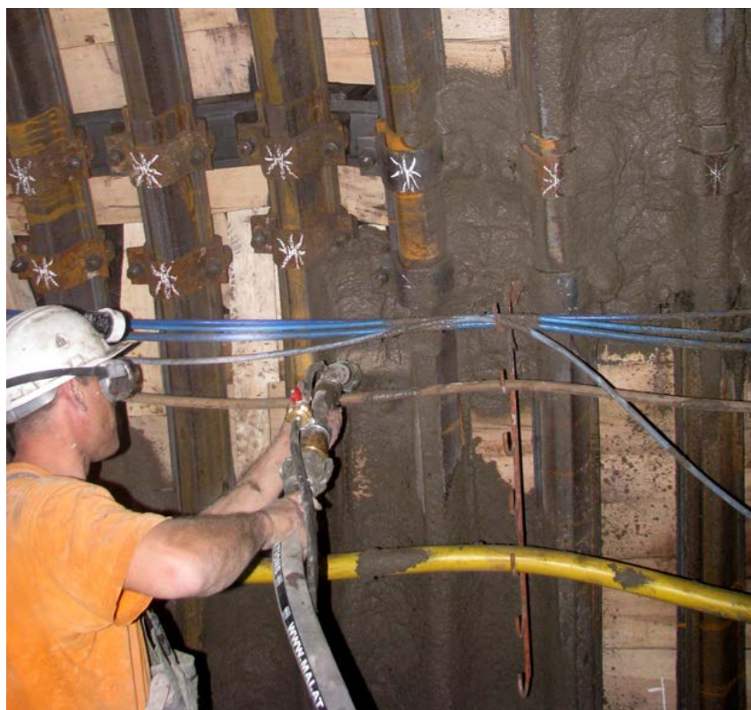
Prikaz nanašanja malte z ustrezno šobo – za delavcem skoraj ni bilo treba z zidarsko žlico zgladiti prostora okoli objemk, saj je moč črpalke tolikšna, da te prostore dovolj kakovostno zapolni. Prav tako brez težav zapolnimo večje praznine v obodu proge, tako da skoraj ni treba večjih odprtin prekriti s sanacijskimi deskami.
