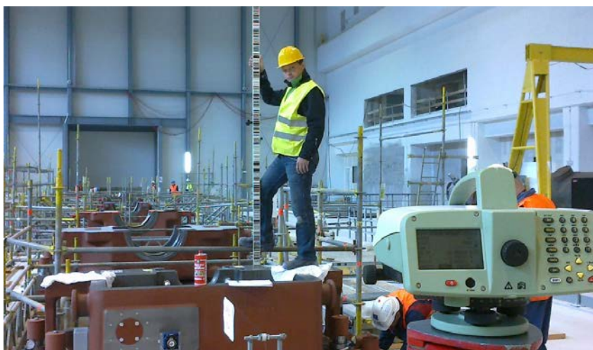
Kontrola višine spodnjega dela ohišja ležajnega bloka (foto: Aleš Žavbi)
