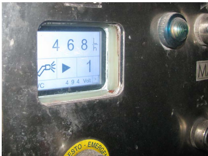
Ekran, na katerem imamo vedno izpisan pretok vode, napetost in način delovanja; prav tako se na njem v spodnjem desnem kotu (na sliki številka 1) izpiše vrsta napake.
