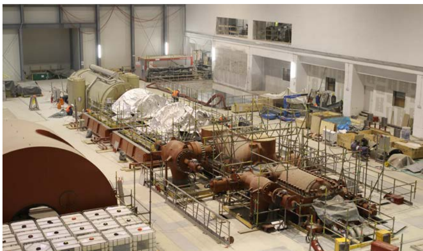
Pogled na turbinsko mizo z generatorjem (foto: Rok Gril)
