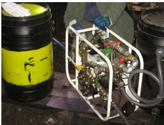
Pripravljena črpalka in dozirni posodi za posamezni komponenti
