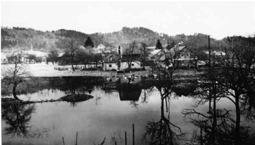
Zaradi odkopavanja premoga so nastale ugreznine, zato je bila potrebna sanacija poškodovanega okolja.
