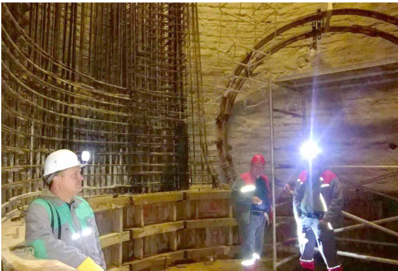
Bogate delovne izkušnje pri izdelavi jaška NOP II prenašamo na sanacijska dela v jašku Dol. (foto: Marko Ranzinger)
