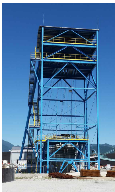
Izgradnjo zračilnega jaška nadaljuje podjetje RGP, ki je izdelalo že njegovih prvih 280 metrov. (foto: arhiv RGP)
