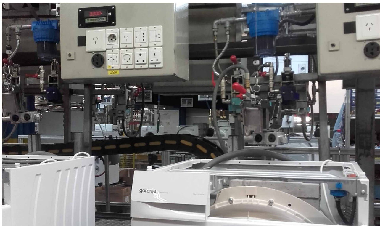
Vgrajeni filtri AquaVallis™ na liniji za testiranje
