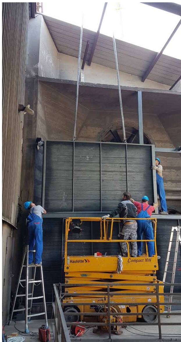
... in vgradnja novih
