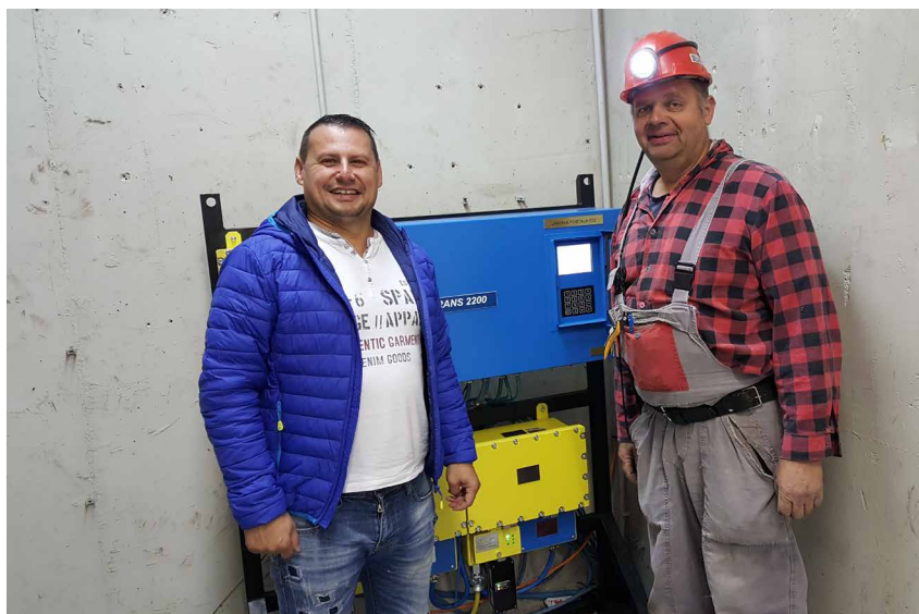
Vgradnja nove JP-033 na lokaciji ventilatorske postaje Šoštanj
