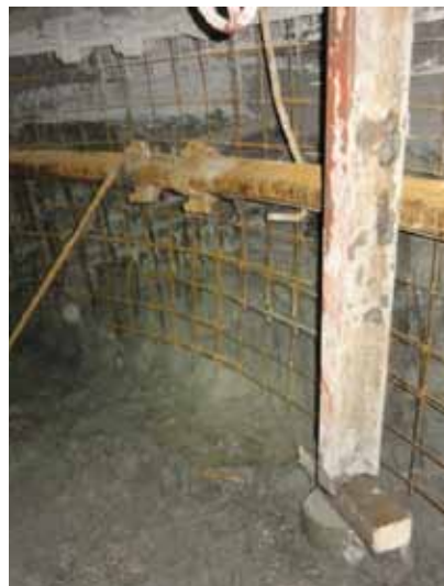
Način izvajanja podpornih ukrepov v primarni podgradnji na globini sto metrov
