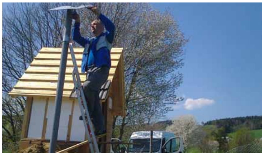
Obnovljen vodohram v Krajevni skupnosti Zgornja Polskava (foto Matej Vošnjak)
