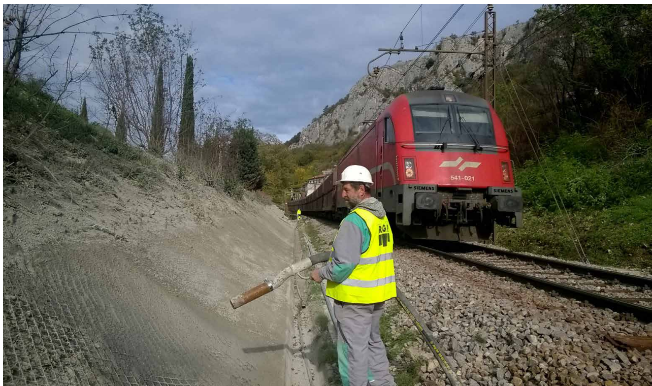
Dela izvajajo z uporabo črpalke za transport suhe betonske mešanice (SBS), ki omogoča pnevmatski transport SBS na velike razdalje. (foto: Marko Ranzinger)
